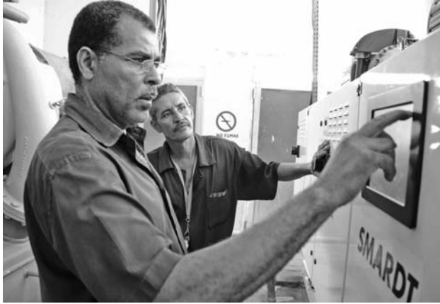
Juan Luis y Virgilio muestran la moderna máquina enfriadora de agua que emplea un refrigerante no nocivo.
